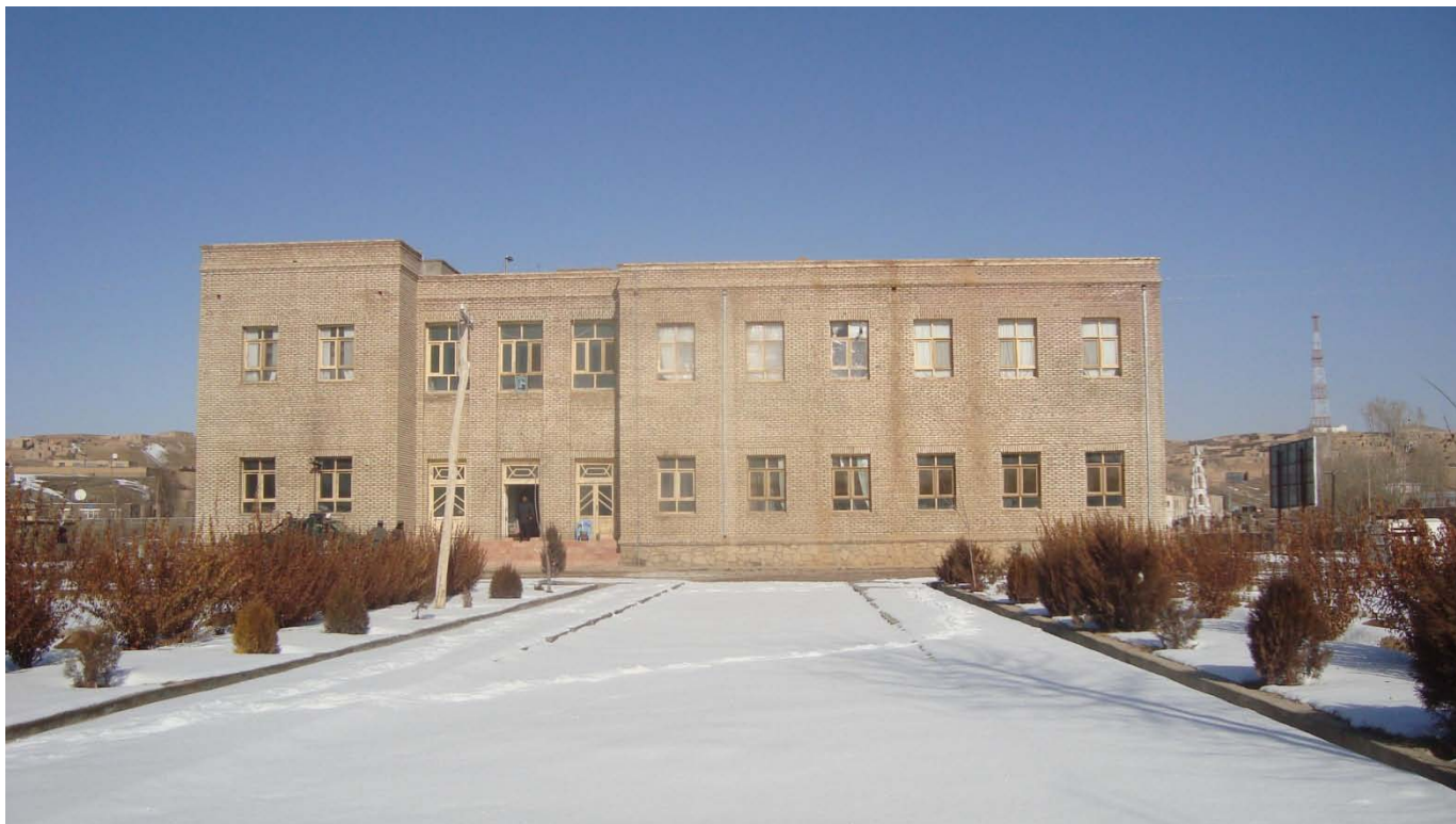
شکل 1: نمایی از تعمیر شهرداری چخچران که همسان و مشابه به تعمیر مکتب دولتیار ساخته شده است. اما تعمیر مکتب دولتیار زیباتر ازین بود. 7
